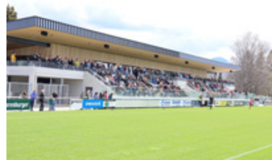
Fertiggestellte Sportanlage Lohma
